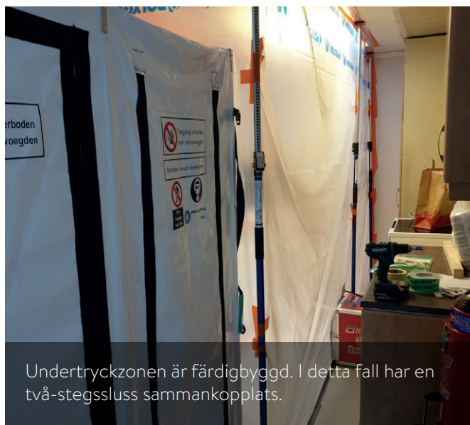
Utförda intäckningsmoment under en byggnation av en undertryckzon.
