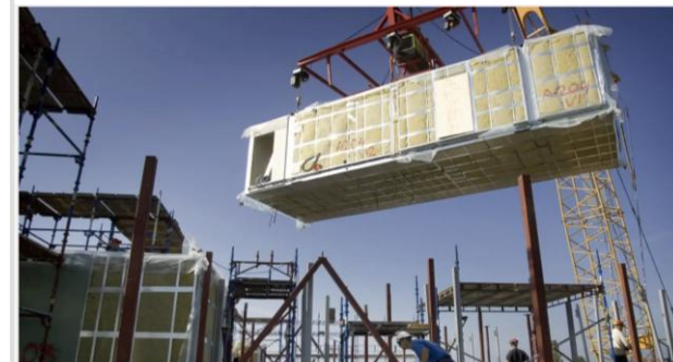
Lägenhetsmoduler tillverkas i fabrik för att sedan snabbt monteras vid byggarbetsplatsen. Foto: Bonny Håkansson
