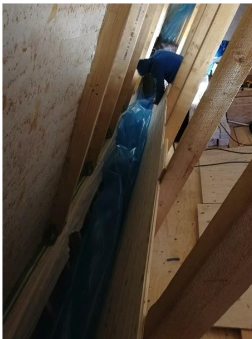
Figur 4.3. Visar utrymmet mellan takstolarna i Skeppet innan utrymmet fylldes med lösull.
