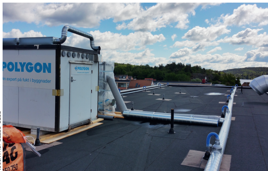
Figur 4: Forceringstorkning av ett uppfuktat mineralullstak.
