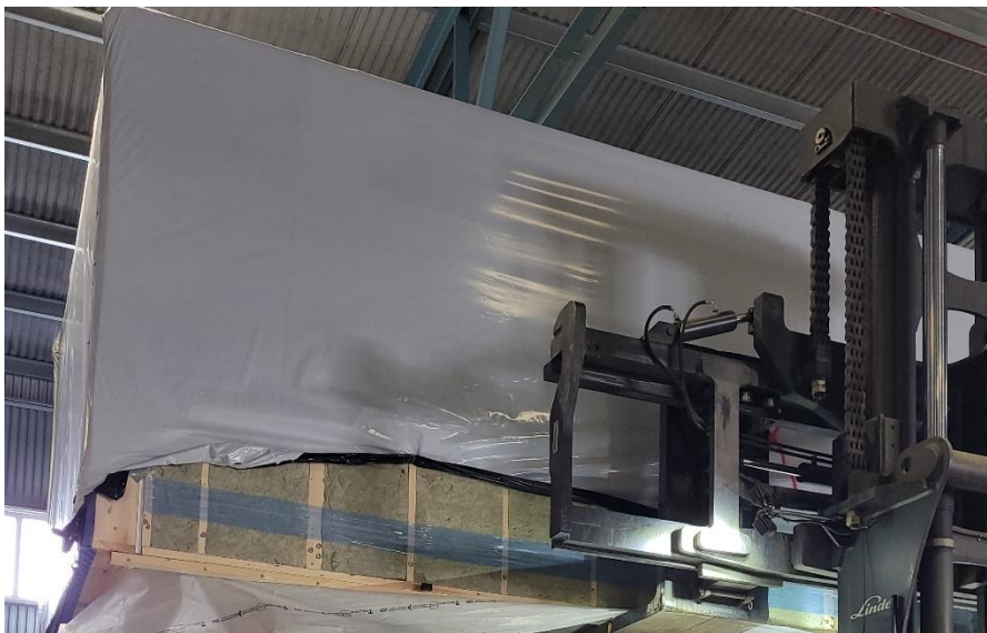
Figur 5.1 Modul som avtäckts, instrumenteras och ställs upp för torkning under väderskydd i Öjebyn.
