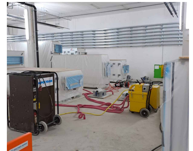
Aktuelles Bild der Trocknung vor Ort.
