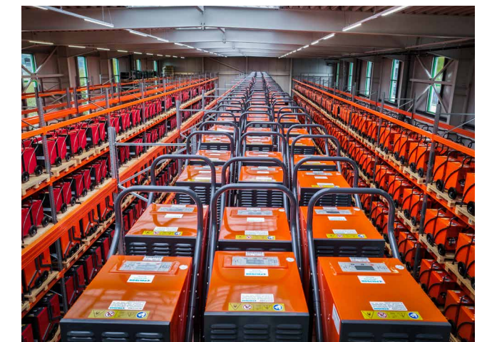
Unser Logistisches Zentrum II vor dem Hochwasser.
