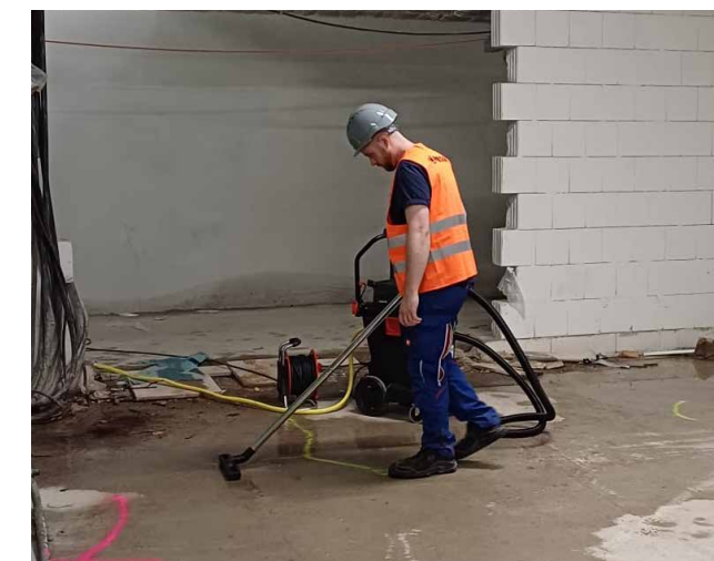
Regelmäßiges Absaugen unterstützt die Trocknung vor Ort und verhindert weitere Schäden.
